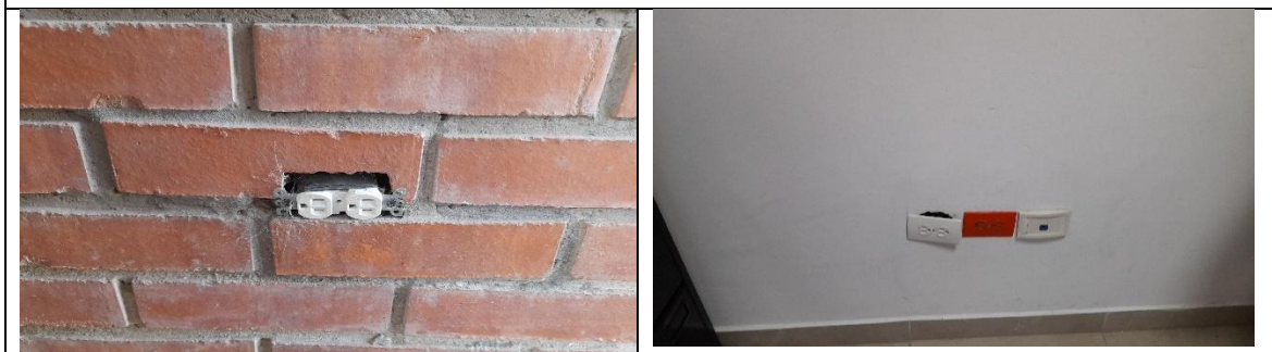
Deficiencias constructivas en las instalaciones eléctricas.
